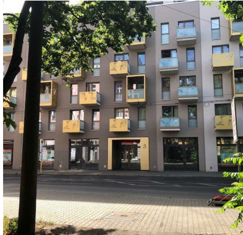
Abbildung 6: Gegenüberliegende Grundstücksausfahrt zur Dörpfeldstr. Quelle: BIM Berliner Immobilienmanagement GmbH
